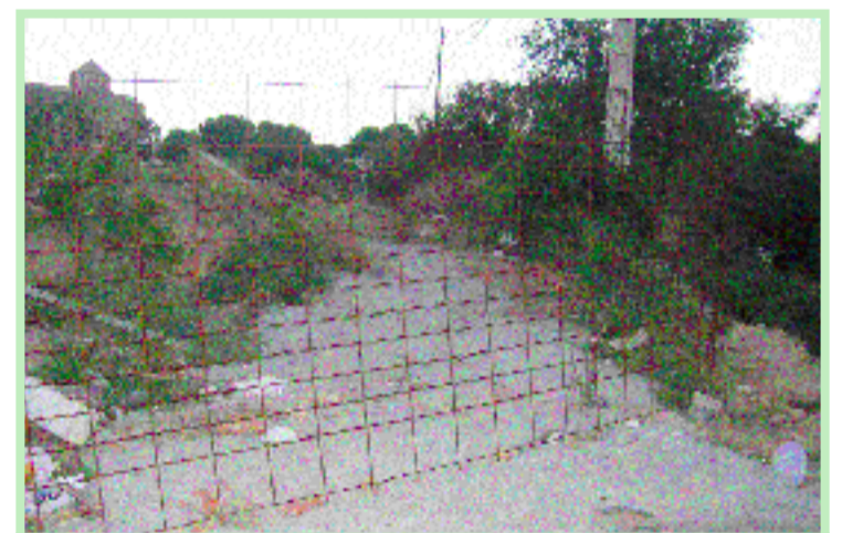
CAMÍ PÚBLIC TALLAT Les obres de construcció d'habitatges han tallat des de fa mesos el pas per un espai públic com és el del carrer de la Vinya Gran.
