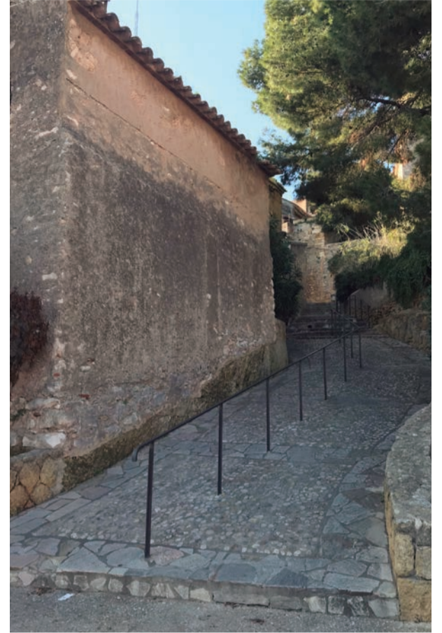
Les muralles darrera l'Hostal. Agafats a la història del poble per no perdre el pols a l'edifici més antic de la Vila, ara propietat municipal i en un futur un nou espai recuperat
