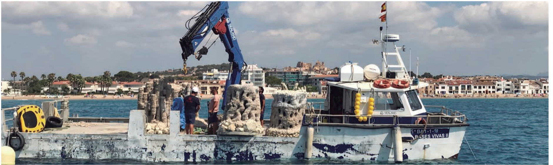
Parc de biòtops. Un acord amb Repsol ha suposat la creació d'un parc de biòtops de carbonat càlcic que donen vida submarina a la fins ara quasi desèrtica platja d'Altafulla
