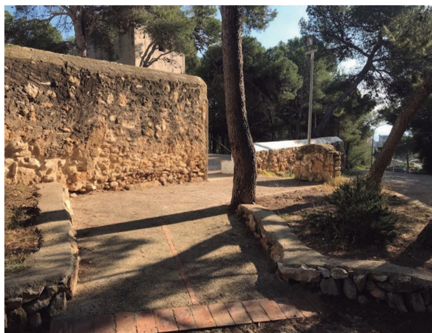
Rampa d'accés a l'Ermida de Sant Antoni. Arreglar l'entorn, podar i treure arbres i facilitar l'entrada a les persones amb handicap físic
